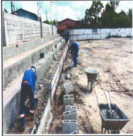
FOTO - 04:CAMADA SEPARADORA PARA EXECUÇÃO DE RADIER, PISO DE CONCRETO OU
