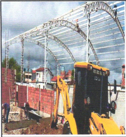
FOTO - 03:ESTRUTURA TRELIÇADA DE COBERTURA, TIPO ARCO, COM LIGAÇÕES
