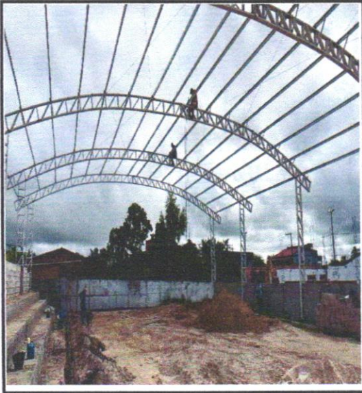
FOTO - 01 :ESTRUTURA TRELIÇADA DE COBERTURA, TIPO ARCO, COM LIGAÇÕES SOLDADAS, INCLUSOS PERFIS METÁLICOS,
