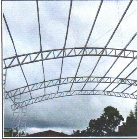
FOTO - 02 :ESTRUTURA TRELIÇADA DE COBERTURA, TIPO ARCO, COM LIGAÇÕES SOLDADAS, INCLUSOS PERFIS METÁLICOS,
